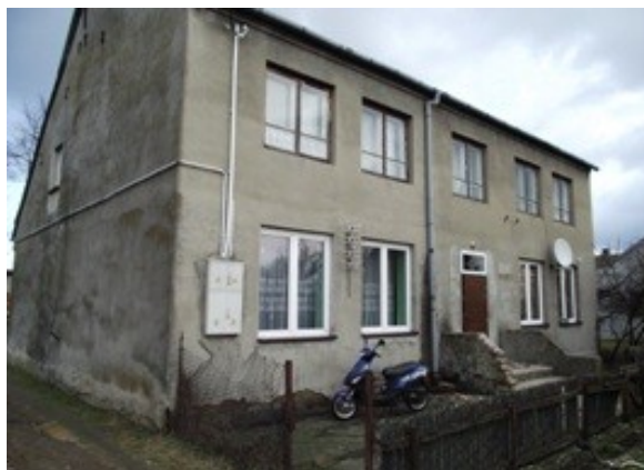
Budynek starej Szkoły w Kielczyglówku
