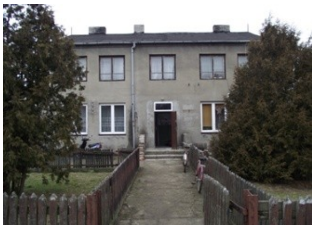
Budynek starej Szkoły w Kielczyglówku
