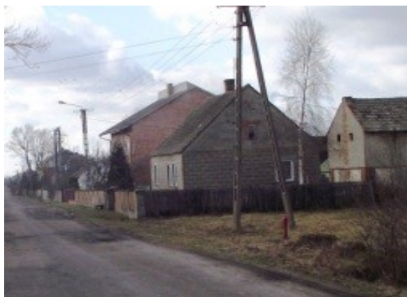
Budownictwo w miejscowości Kielczyglówek
