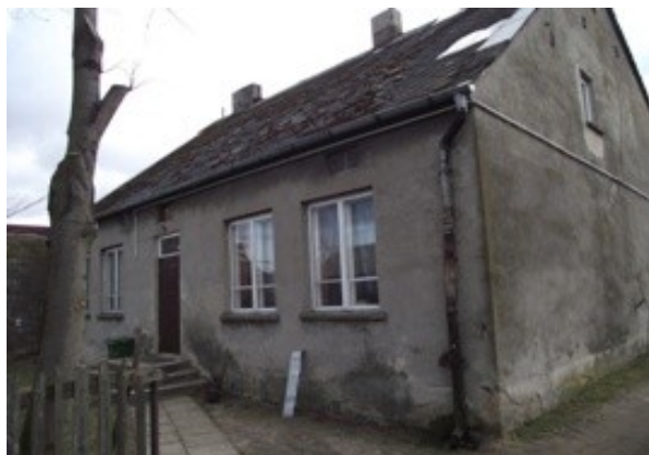
Budynek starej Szkoły w Kielczyglówku
