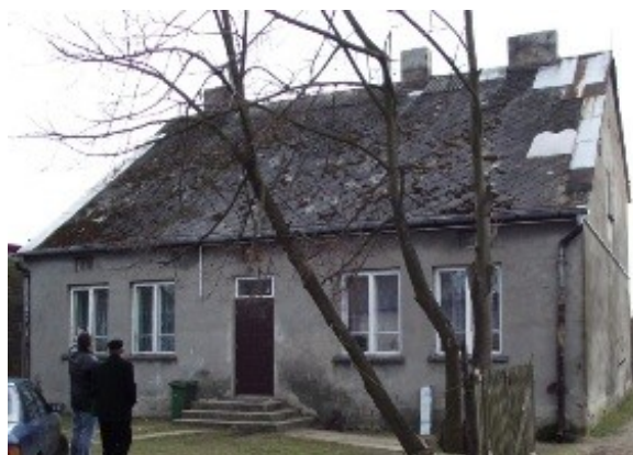
Budynek starej Szkoły w Kielczyglówku
