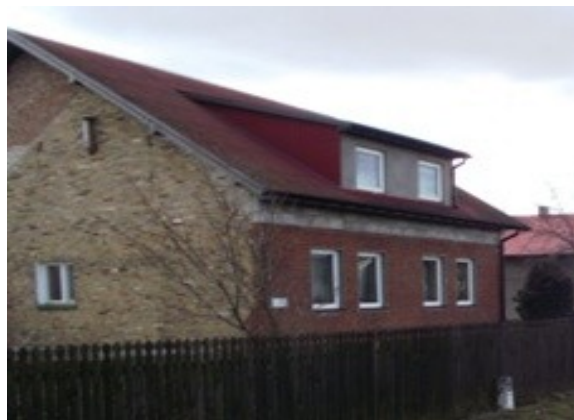
Budownictwo w miejscowości Kielczyglówek
