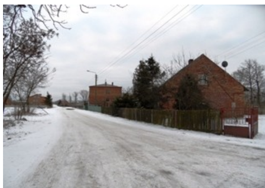
Droga gminna przez miejscowość Huta
