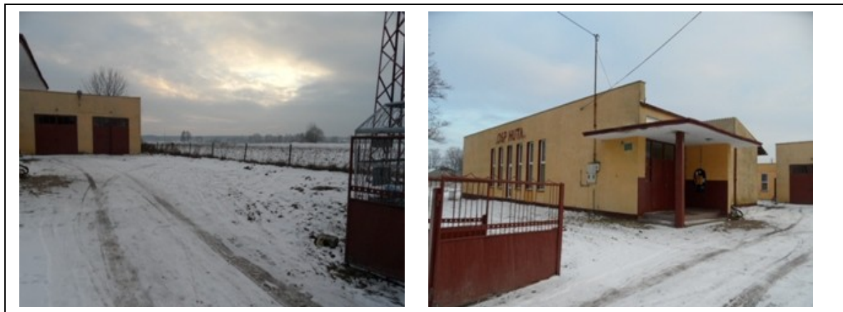
Miejsce na parking przy OSP Huta
