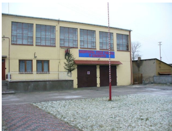
Budynek OSP w Chorzewie
